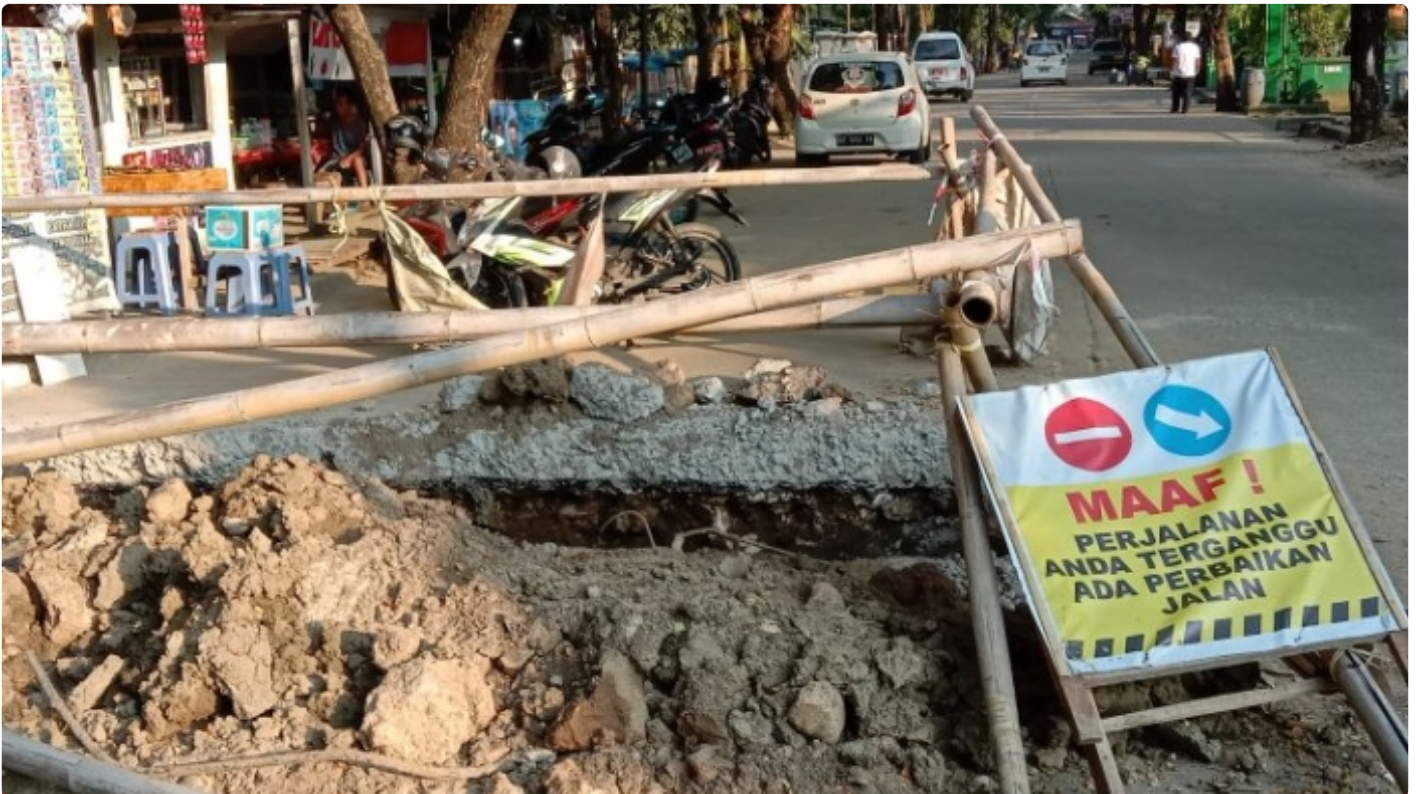
Jalan Cendana dibongkar dan belum dilanjutkan pekerjaannya
